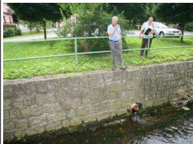
Foto 211 – Vyústění dešťové kanalizace
