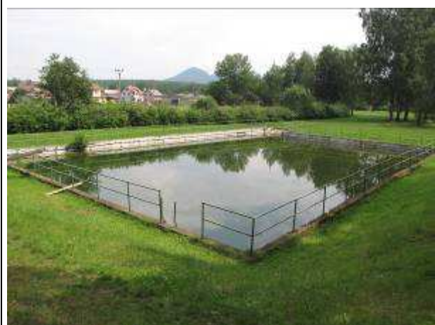
Foto 064 – Požární nádrž v obci Okna
