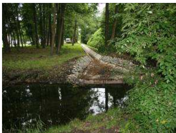
Foto 199 – Zaústění odvodňovacího příkopu podél železnice do Robečského potoka
