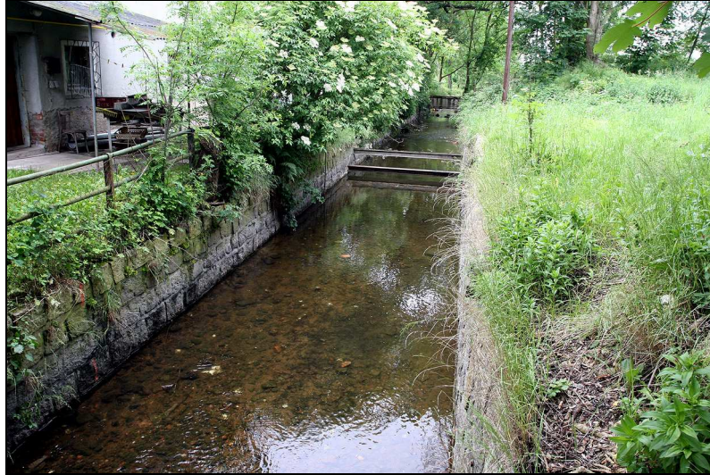
Obr. 3.6-1 Profil č.1 je situovaný pod výpustí z Máchova jezera. (Pohled po vodě, stav z 2.6.2009)
