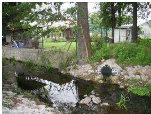
Foto 203 – Zpětná klapka na vyústění dešťové kanalizace
