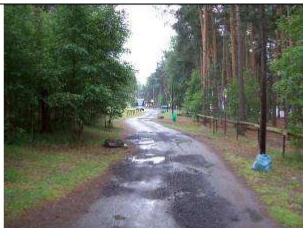
Foto 588 – Šachta kanalizace podél komunikace v kempu Borný
