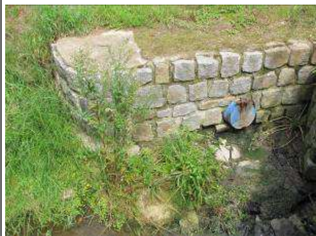
Foto 060 – Zpětná klapka na odpadu z bytovek v obci Okna
