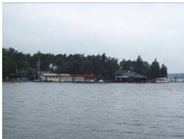
Foto 598 – Objekt loděnice, budovy o.p.s. Máchovo jezero
