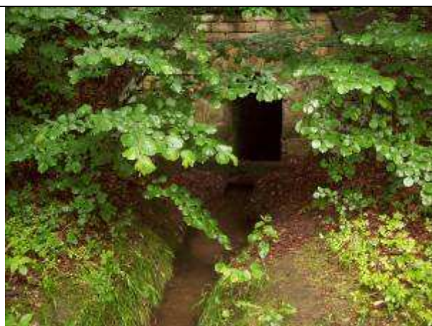
Foto 600 – Propustek pod železnicí - přítok ze zemědělských ploch
