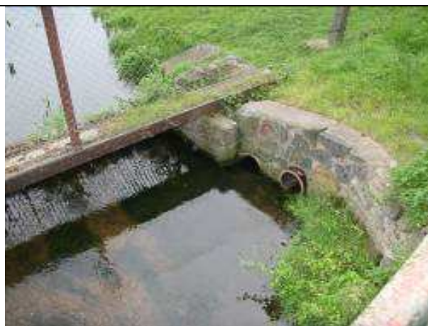
Foto 235 – Odlehčení přečerpávací stanice splaškových vod v Doksech – bez průtoku
