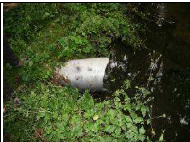
Foto 201 – Odlehčení - bezpečnostní přepad z čerpací stanice splašků
