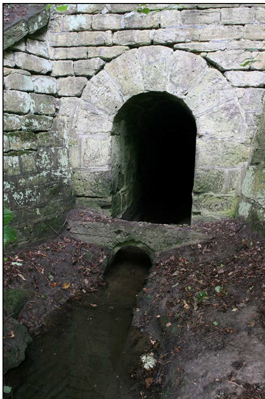
Obr. 3.6-13 Profil č.8 je situovaný na bezejmenném levostranném přítoku Máchova jezera v profilu pod drážním tělesem v úrovni železniční zastávky Doksy. (Pohled proti vodě na dolní profil měrného úseku, stav z 11.8.2009)
