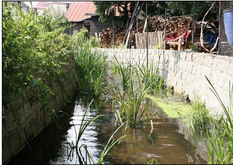
Obr. 3.6-5 Profil č.4 je situovaný v obci Doksy za prodejnou PENNY. Měrný úsek zahrnuje pouze obdélníkové koryto, které je opevněné kamennou dlažbou. (Pohled proti vodě, stav z 11.8.2009)
