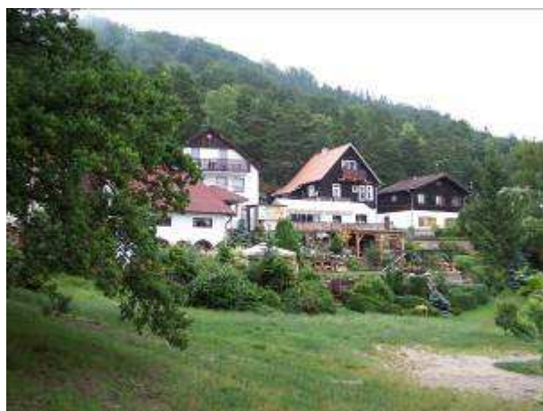
Foto 578 – Domy na pravém zavázání hráze, odkanalizováno gravitačně
