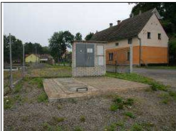
Foto 238 – Přečerpávací stanice splašků Doksy
