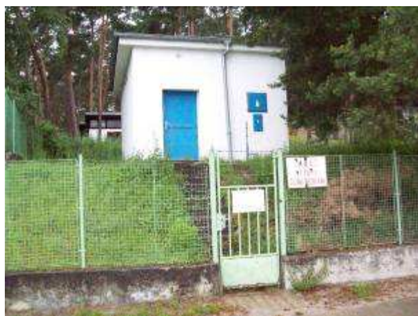
Foto 565 – Čerpací stanice odpadních vod v areálu Poloostrov
